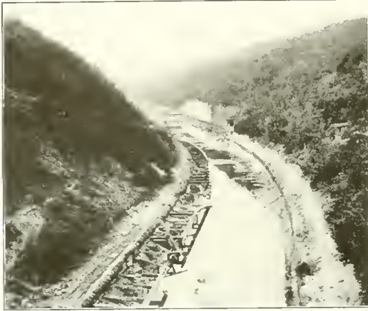
THE CANAL DU NORD
